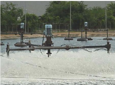
รูปที่ 1-2 การเติมอากาศที่ผิวน้ำด้วยวิธีต่าง ๆ
