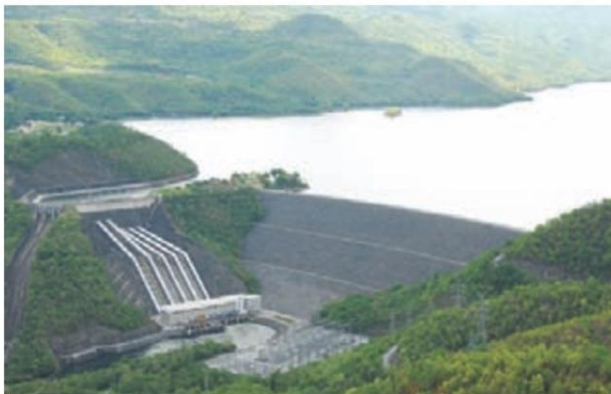
เขื่อนศรีนครินทร์ ต.ท่ากระดาน อ.ศรีสวัสดิ์ จ.กาญจนบุรี
